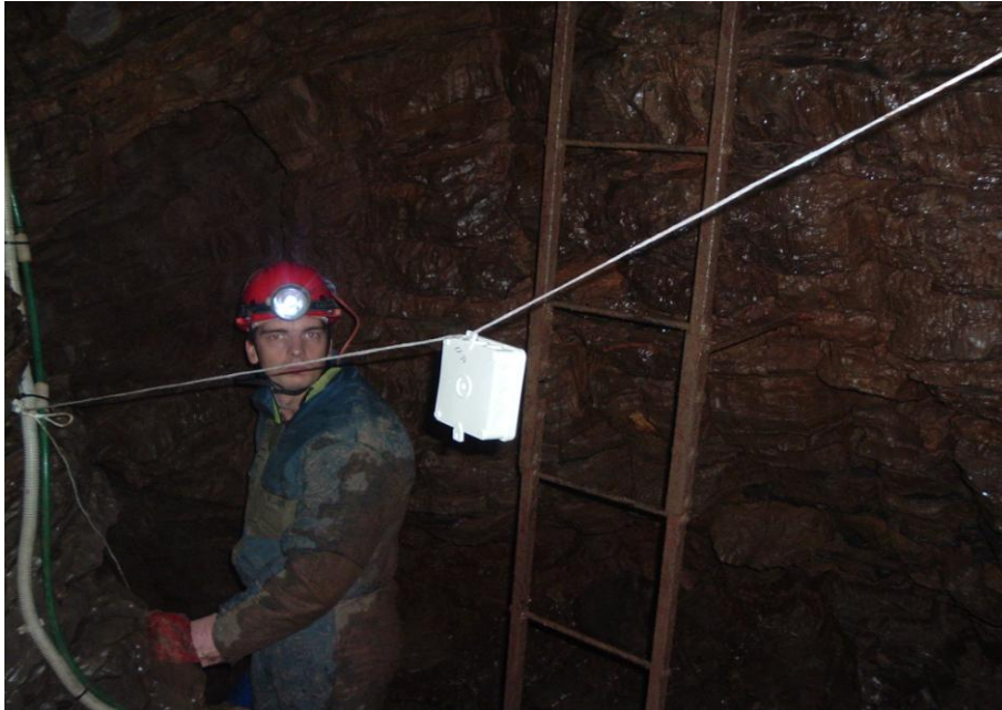
8. ábra: Hőmérsékleti szenzor telepítése, 2010.
